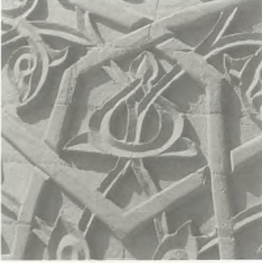
Memlük Sultanı Kayıtbay Türbe Külliyesi kubbesi (Kahire, Mısır, 1472)
